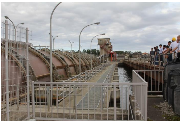
(新川河口排水機場)
